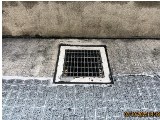
รูปที่ 3.1-10 ตะแกรงดักมูลฝอยภายในบ่อพักน้ำ ก่อนระบายออกสู่สาธารณะ
