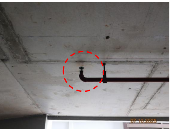
รูปที่ 3.1-22 หัวกระจายน้ำดับเพลิง
