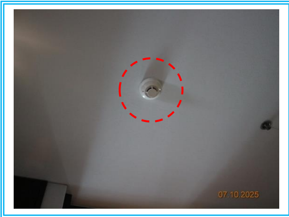
รูปที่ 3.1-24 Smoke Detector
