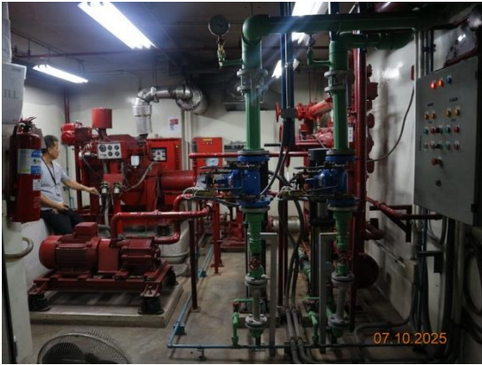
รูปที่ 3.1-18 ระบบสูบน้ำสำหรับดับเพลิง
