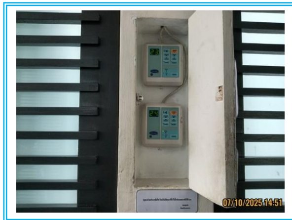
รูปที่ 3.1-44 การติดตั้งสวิทช์เปิด/ปิดเครื่องปรับอากาศ แยกออกจากกันในแต่ละพื้นที่ของอาคาร
