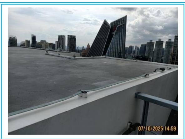
รูปที่ 3.1-45 ระบบป้องกันฟ้าผ่า
