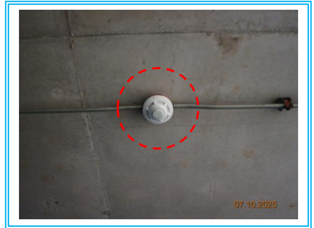
รูปที่ 3.1-25 Heat Detector
